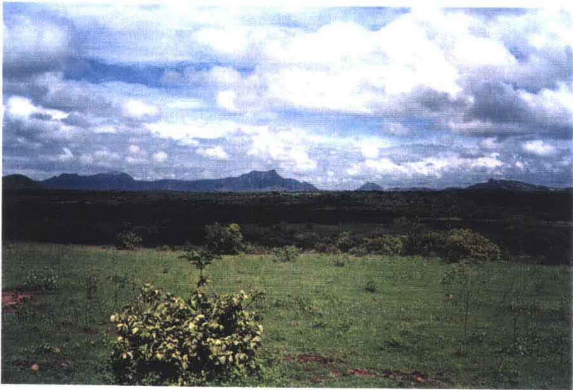
FOTO 2 – Vista geral ao longo do eixo da barragem de Taquara da ombreira direita para a esquerda verificando-se pequena cobertura de solo coluvionar.
